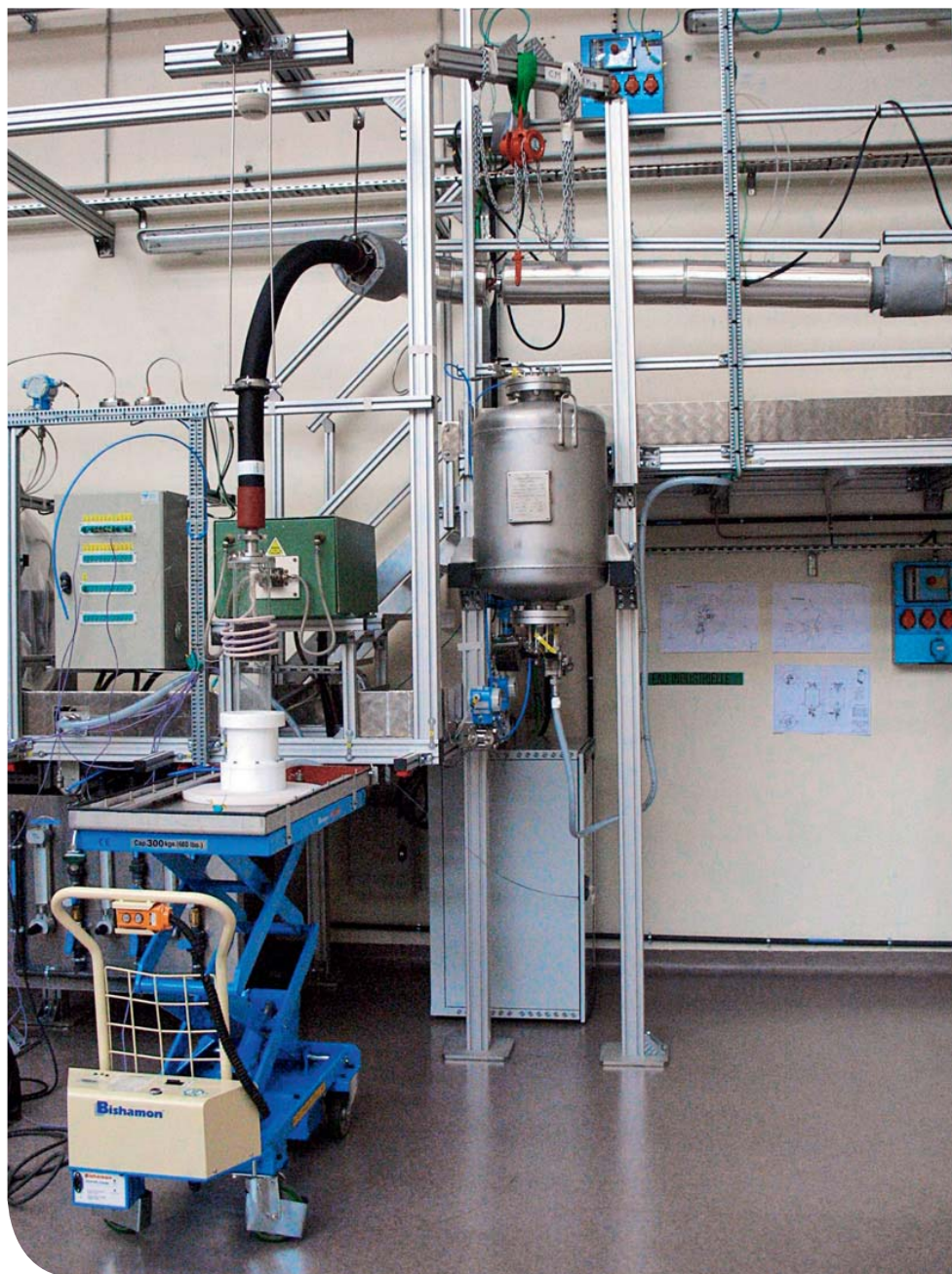
Installation PRÉLUDE prototype de PEARL à échelle réduite.
