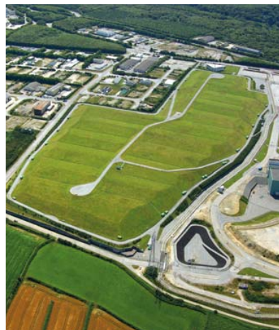
Le Centre de stockage de la Manche.
