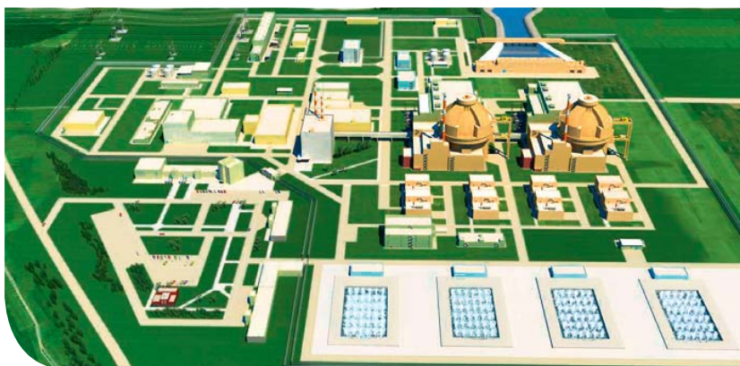
La centrale de Bélény (Bulgarie) comportera trois réacteurs de type VVER.
