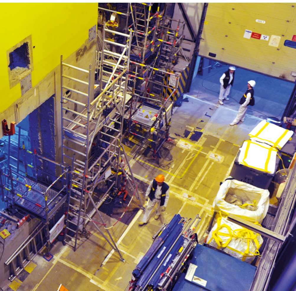
Démantèlement d'installations anciennes de La Hague : cellule de reprise du silo HAO de l'usine UP2-400.
