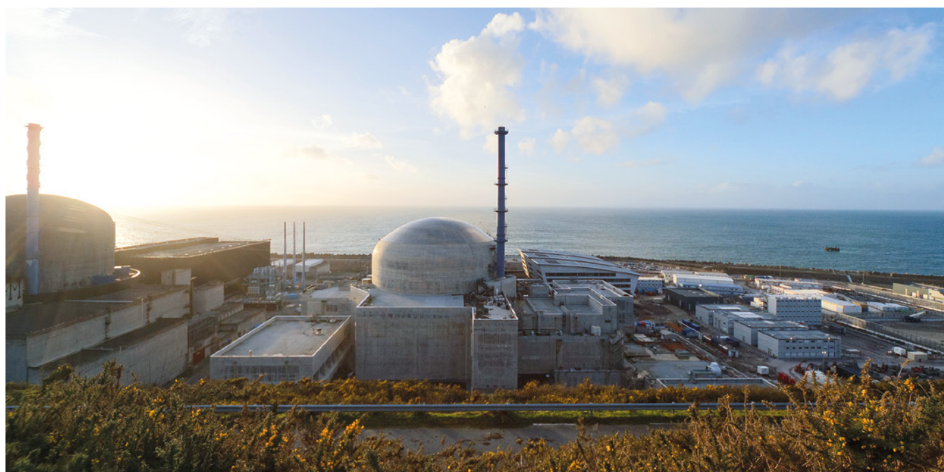
Le réacteur n° 3 de type EPR du CNPE de Flamanville a fait l'objet d'une demande d'autorisation pour détention et utilisation de matières nucléaires transmise par EDF aux services du HFDS.
