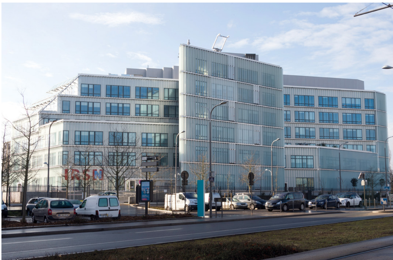
À Fontenay-aux-Roses, le bâtiment 01 livré en 2017, répond à des critères élevés en matière d'économie d'énergie, de fonctionnalité et de confort. Il dispose de la certification « NF bâtiment tertiaire ».
