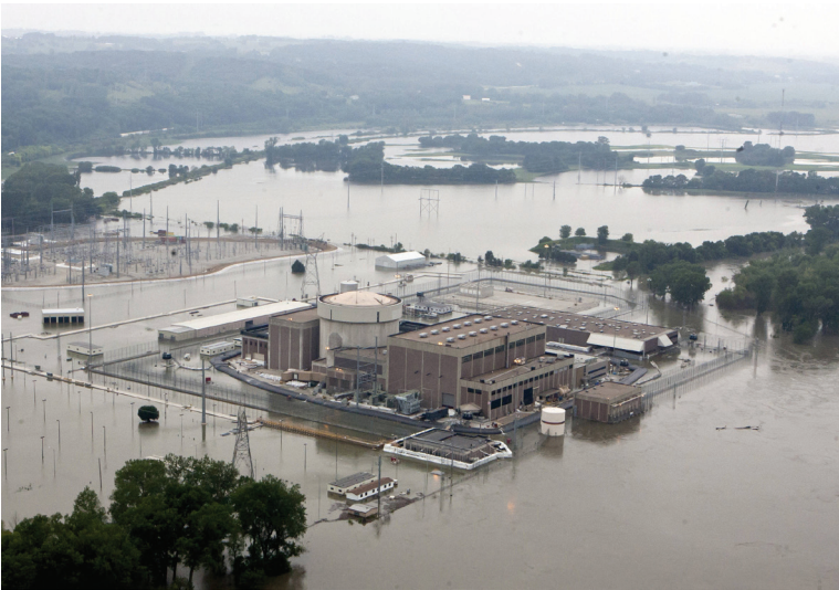
Figure 37.5. Au mois de juin 2011, une crue du Missouri a entraîné l'inondation de la centrale de Fort Calhoun aux États-Unis. Nati Harnik/AP/SIPA.
