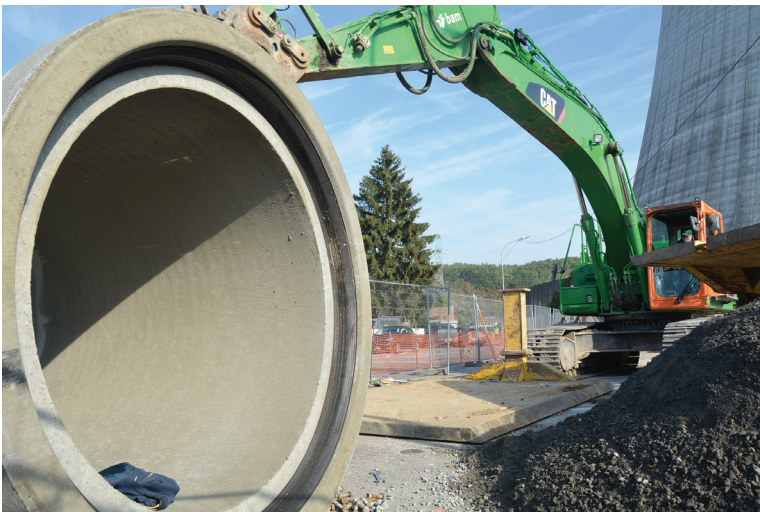
Figure 37.3. Vue montrant les travaux de déviation du pertuis communal en amont du site de Tihange. Centrale nucléaire de Tihange.
