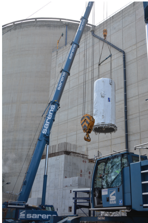
Figure 37.4. Installation du filtre à Tihange 3. Centrale nucléaire de Tihange.
