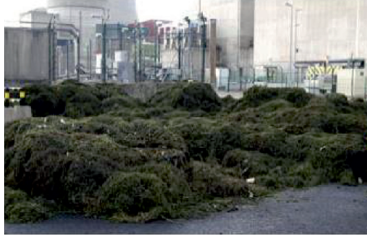
Figure 24.3. Amas de plantes à l'origine du colmatage survenu à la centrale de Cruas-Meysses au début du mois de décembre 2009. EDF.
