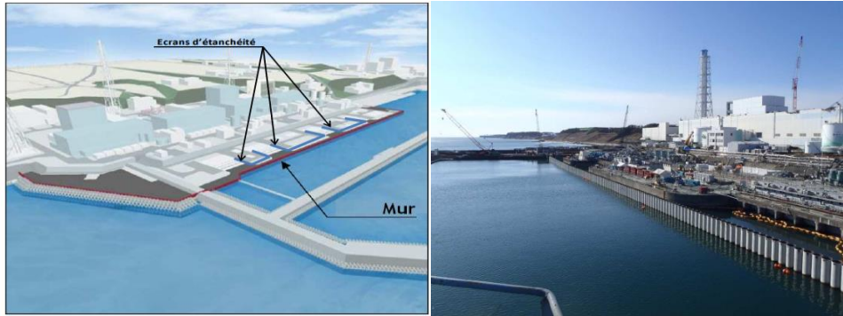
Source TEPCO : écrans et « mur » d'étanchéité côté port
