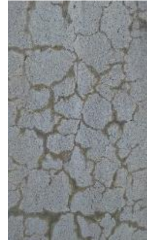
Illustration d'un faiencage dû à la RAG
