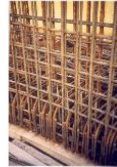
Armatures en acier
