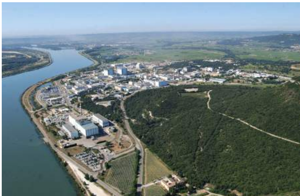
Vue aérienne du site de Marcoule
