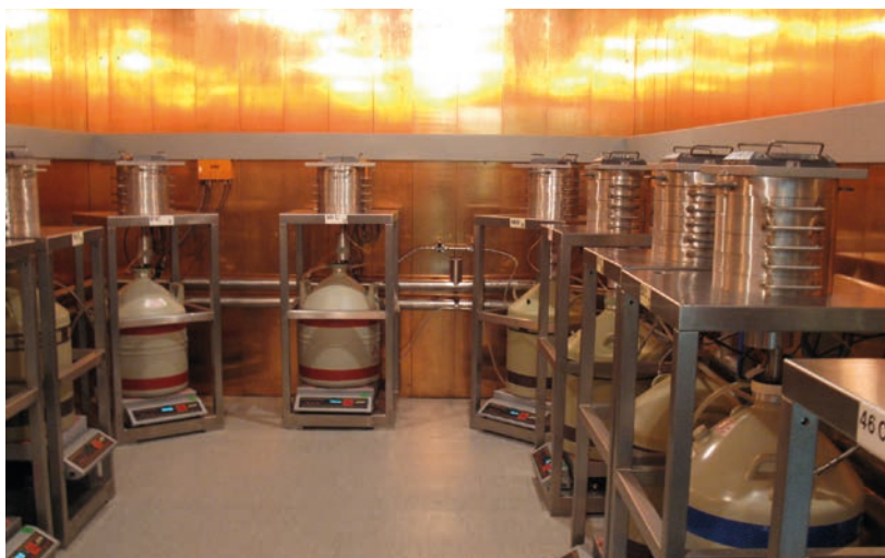
Salle des détecteurs de spectrométrie gamma de l'IRSN à Orsay permettant des mesures de très bas niveaux d'activité
