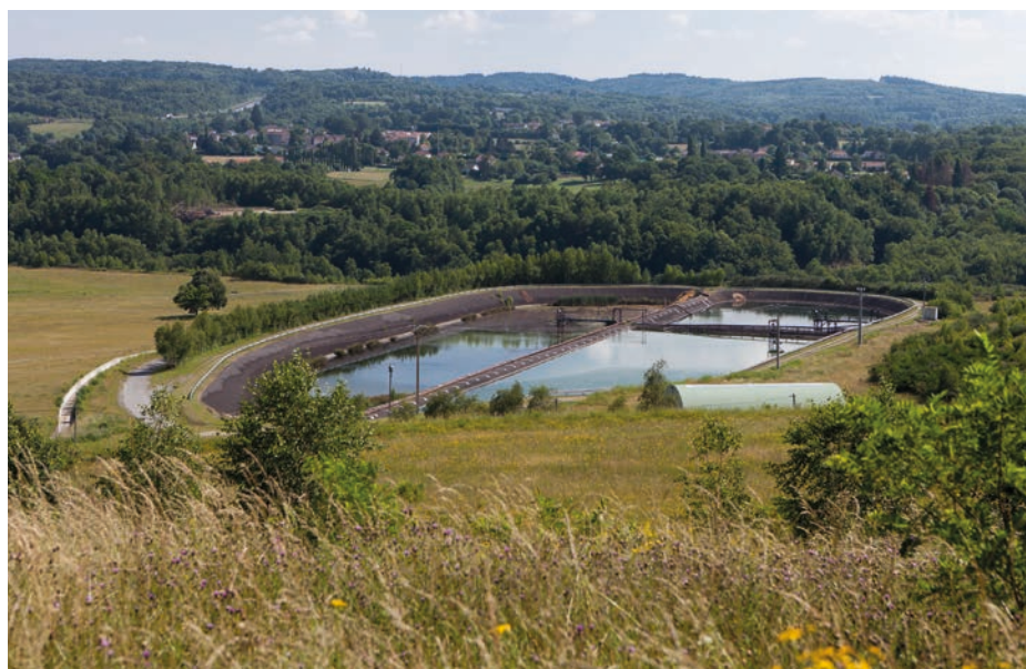
Station de Traitement des Eaux du SIB
