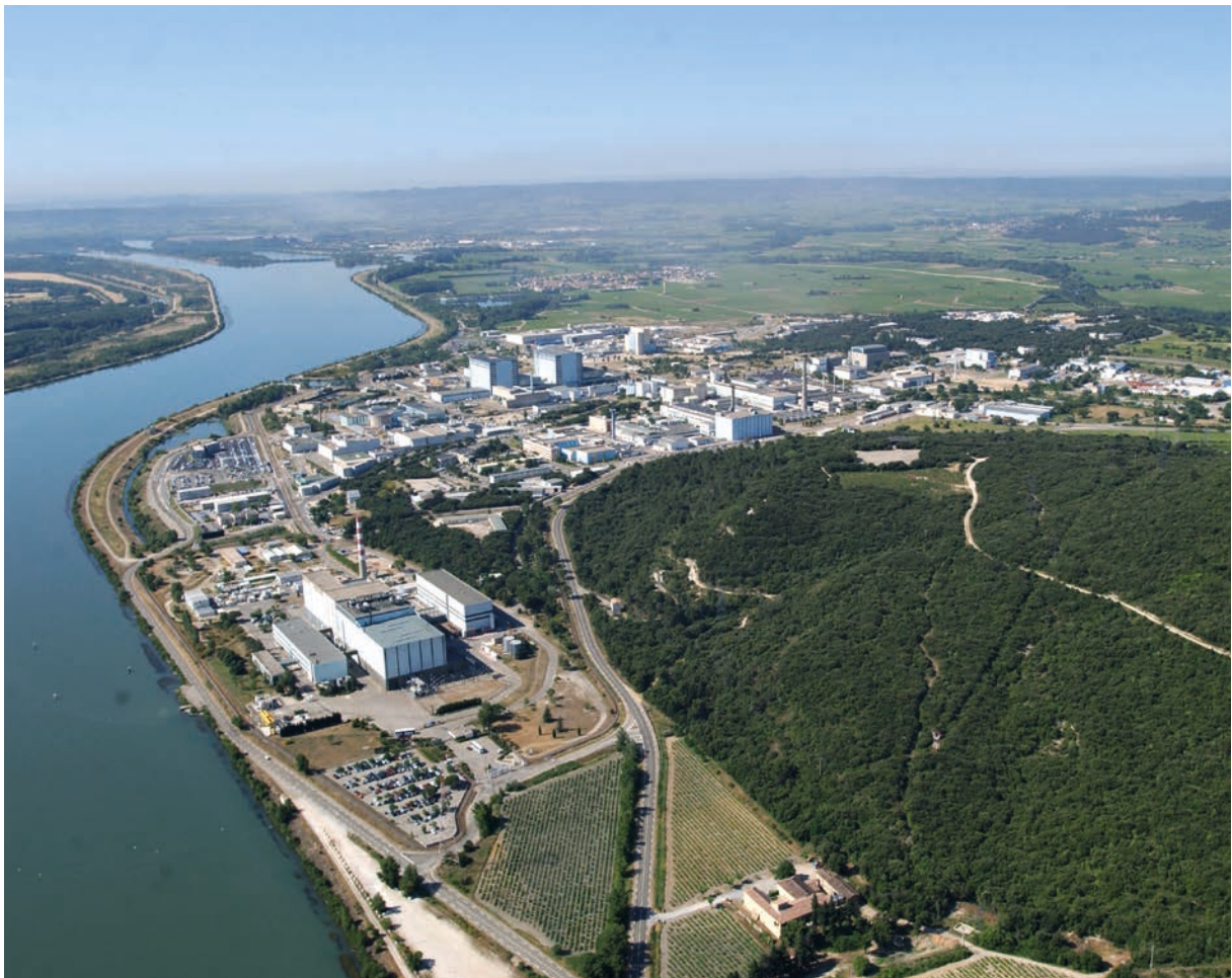
Vue aérienne du site de Marcoule
