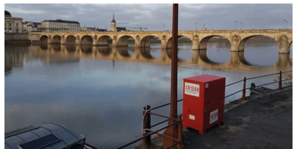
Hydrocollecteur en rive droite
