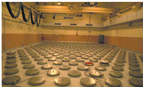
Figure 7 : Exemple d'installation de puits d'entreposage.
