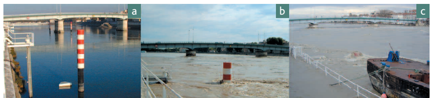
Figure 1 : Prise d'eau de la station OPERA d'Arles – a : à l'étiage ; b : en situation de crue centennale ; c : en situation de crue exceptionnelle.
