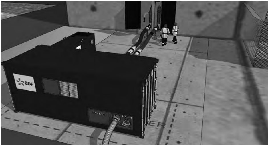
Figure 30.4. Vue en simulation du « PTR bis », montrant au premier plan les éléments abritant la pompe et l'échangeur et au second plan les raccords-pompiers. EDF.
