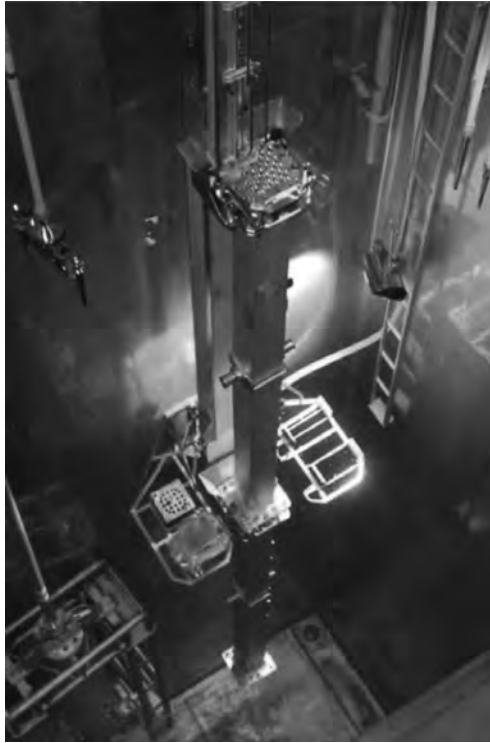
Figure 28.6. Vue du dispositif de « resquelettage » STAR dans la piscine du bâtiment du combustible. EDF.
