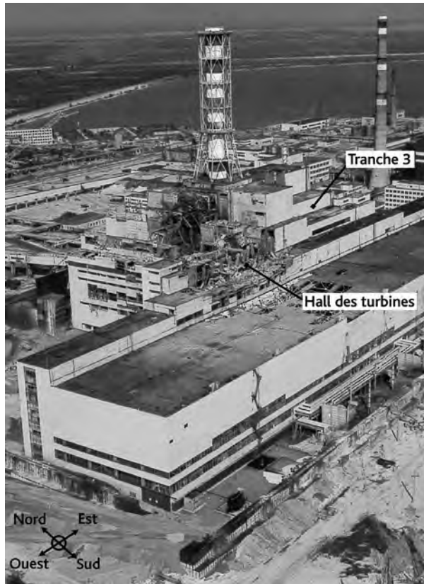
Figure 34.2. Le réacteur n° 4 de la centrale nucléaire de Tchernobyl après l'accident.
