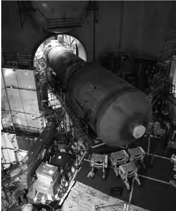
Figure 27.10. Générateur de vapeur neuf en cours d'introduction dans un bâtiment de réacteur par le tampon d'accès des matériels. Jean-Marie Huron/Signatures/Médiathèque IRSN.
