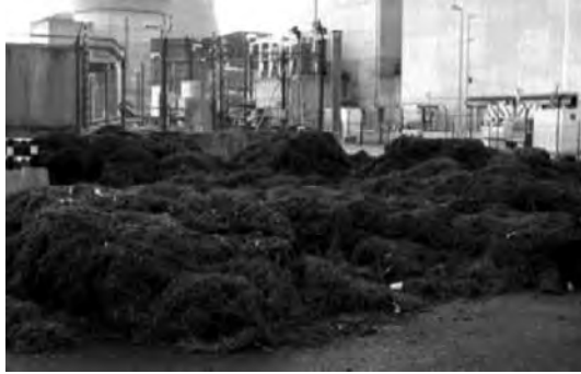
Figure 24.3. Amas de plantes à l'origine du colmatage survenu à la centrale de Cruas-Meyssse au début du mois de décembre 2009. EDF.
