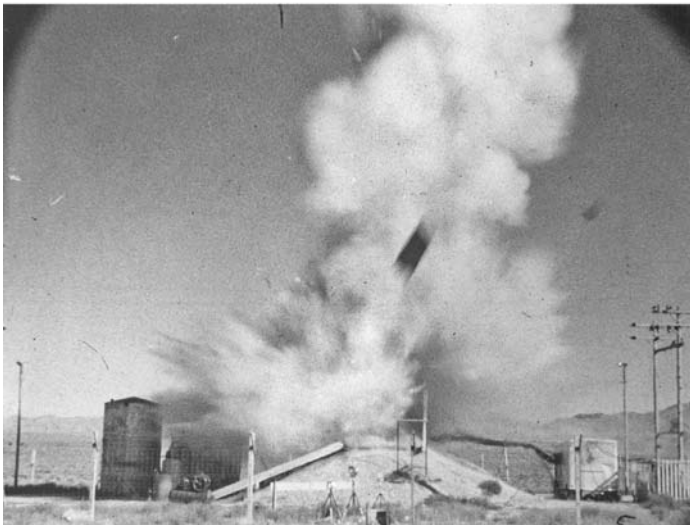
Figure 8.3. En haut, schéma du réacteur BORAX-1. © DR. En bas, photographie prise lors de l'essai destructif final du réacteur BORAX-1. © Argonne National Laboratory ( creative commons ).
