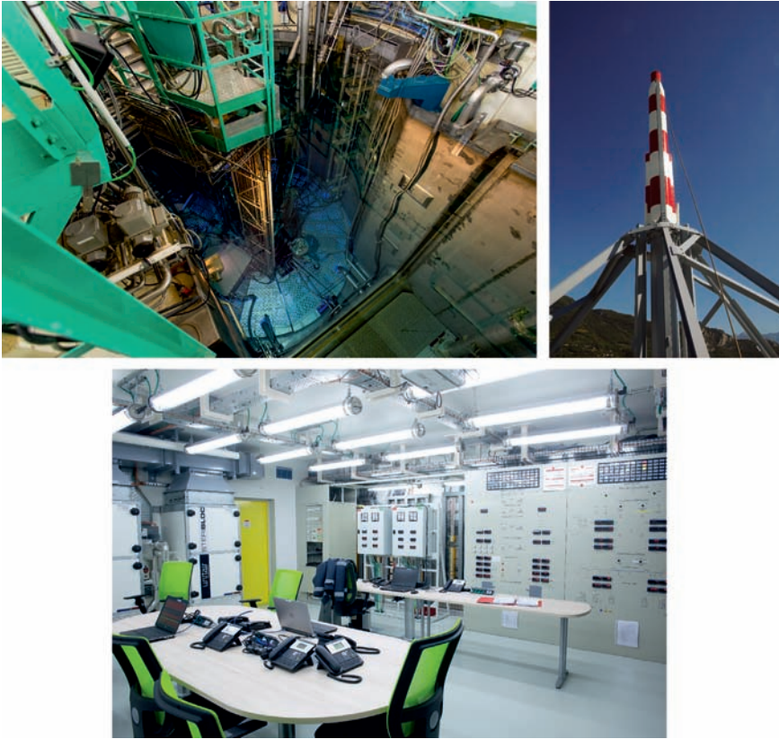
Figure 10.9. Trois dispositions retenues pour le RHF après l'accident de Fukushima Daiichi, toutes conçues et dimensionnées au séisme et à l'inondation extrêmes : en haut à gauche, apparaît notamment le coude d'arrivée dans la piscine du circuit CEN. © IRSN, en haut à droite, la cheminée du CDS située sur le dôme de l'enceinte métallique. © ILL, en bas, la salle de gestion de crise au PCS 3. © Jean-Marie Huron/Signatures/IRSN.
